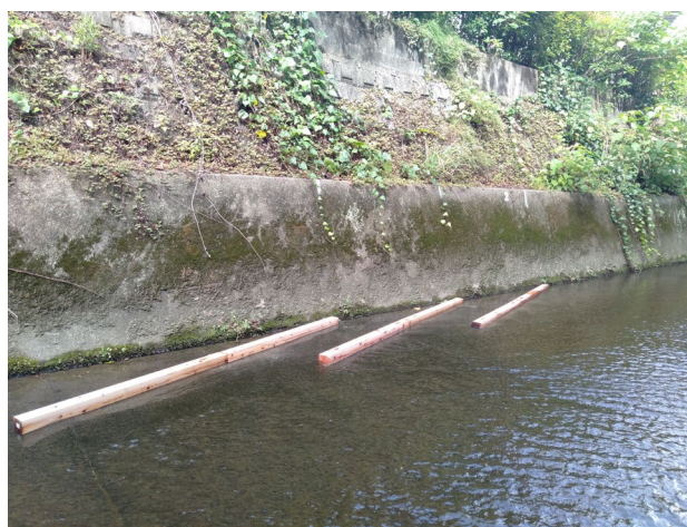
バープ工による水際環境再生
