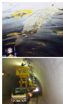
老朽トンネル検査診断
